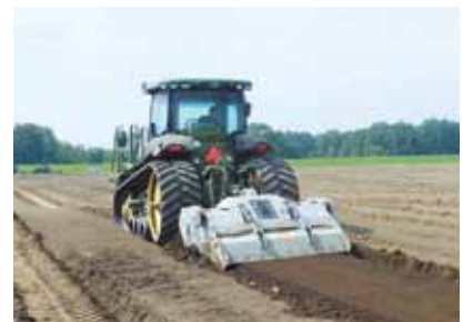
石れき破碎工法
