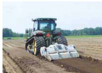
石れき破碎工法
