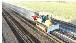
▲ 土壤改良材散布
