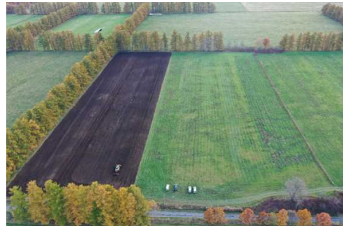
▲ 機械施工実施状況
