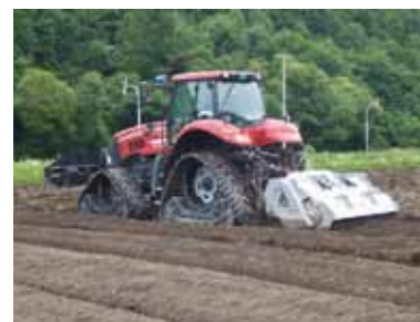
石れき破碎工法
